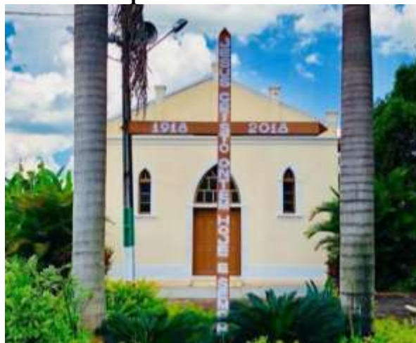
Foto 78 – Capela Santo Antonio de Padova
