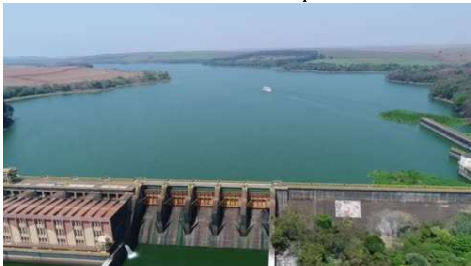
Foto 99 – Hidrelétrica Mário Lopes Leão
